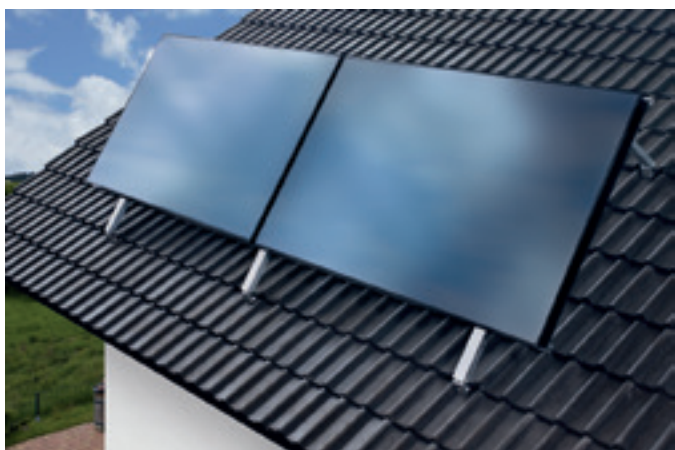
Montáž na střechu s úpravou sklonu
