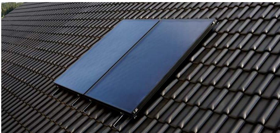
Montáž na střechu s vertikálními kolektory
