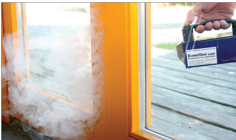
Určování netěsností mlhovým generátorem
